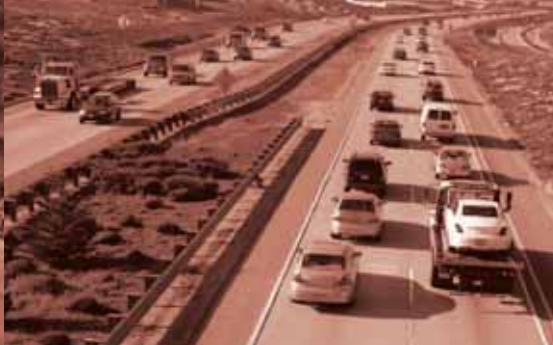
Ensanchamiento de la Ruta 1 en Seaside/Sand City
