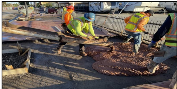
Figure 2 – Baja Red Concrete Sidewalks Pour
